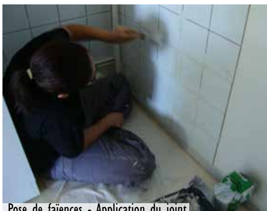
Pose de faïences - Application du joint
